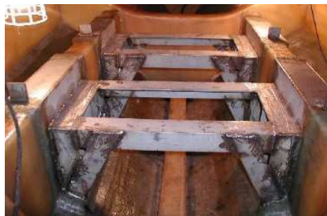
FRP 船に対し、鉄架台を設置した例
